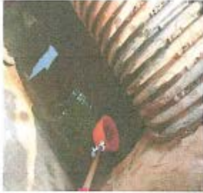
WW1 生活污水排放口
