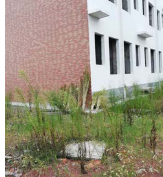
综合楼化粪池
